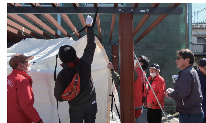
パーゴラテント設営
