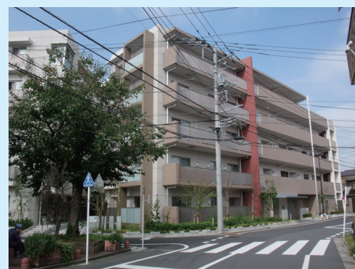
●京島三丁目地区防災街区整備事業 (京島三丁目8番周辺)
