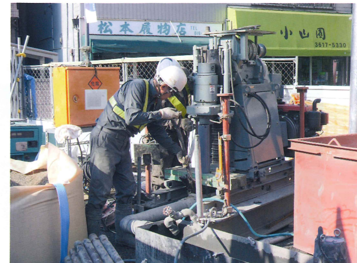
井戸掘削工事の様子 (令和2年10月27日撮影)
