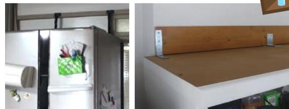
冷蔵庫の転倒防止事例 L字金具を使用した転倒防止事例
