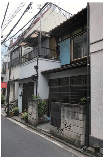
改修前（二軒長屋）
