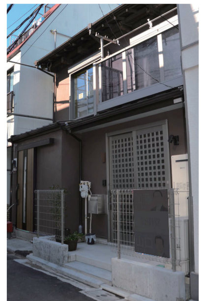
改修後（左側住戸）
