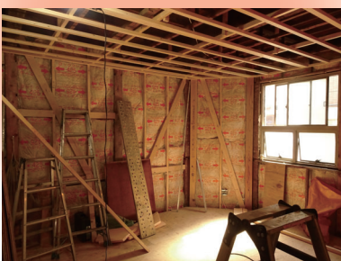
断熱材の施工
