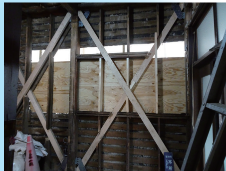
窓を撤去して筋交いで補強
