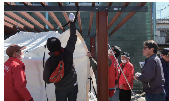
パーゴラテント設営
